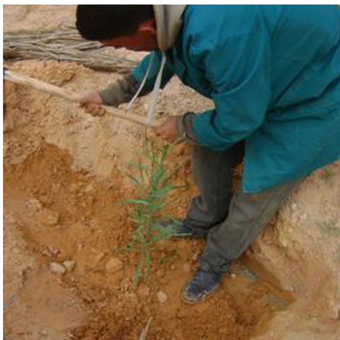
Chantier de plantation et d'irrigation de jeunes plants pour la fixation des sables Mobiles et la protection des infrastructures routières à Medenine - Tunisie (Taamallah Houcine)
