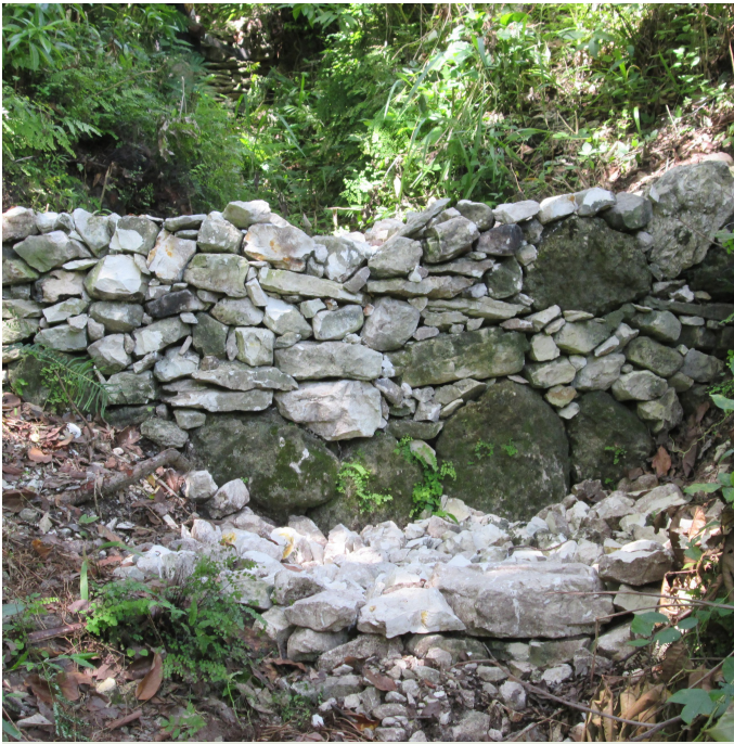
Seuils en pierre sèche, avec radier et mini-seuil (HELVETAS)
