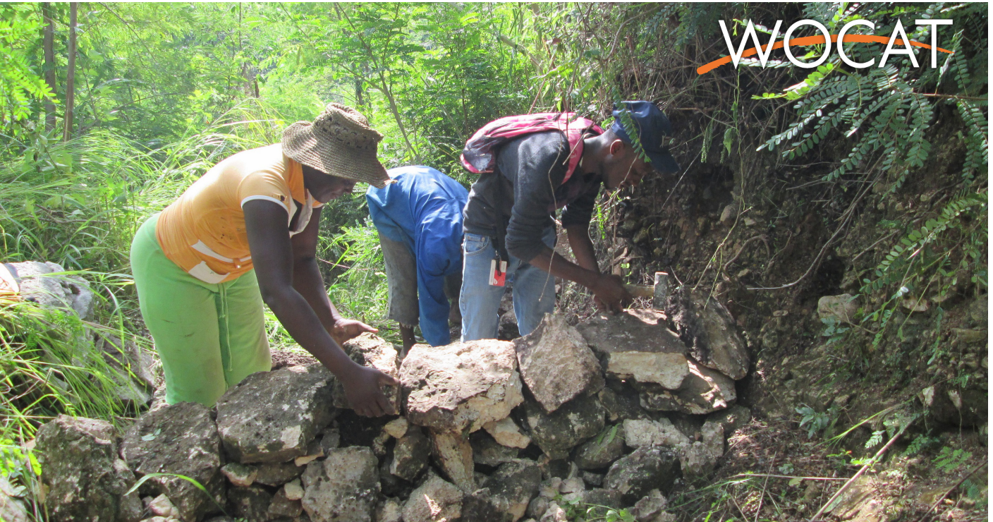
Construction d'un seuil en pierre sèche (HELVETAS)
