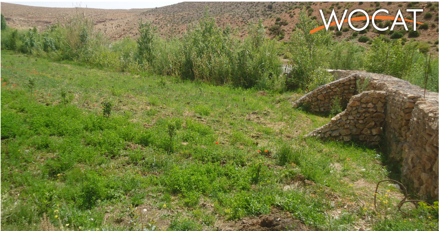
Mur de soutènement en gabion avec contreforts pour protéger les terres cultivées situé sur les berges d'Oued Outat. (Said Aouddou)
