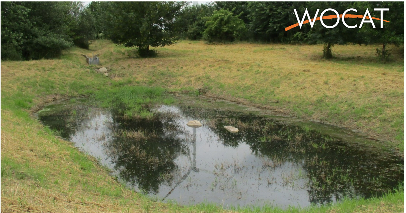
Detention pond (LlSt Gesellschaft für Verkehrswesen und ingenieurtechnische Dienstleistungen mbH, Bereich Kompensationsmaßnahmenmanagement)
