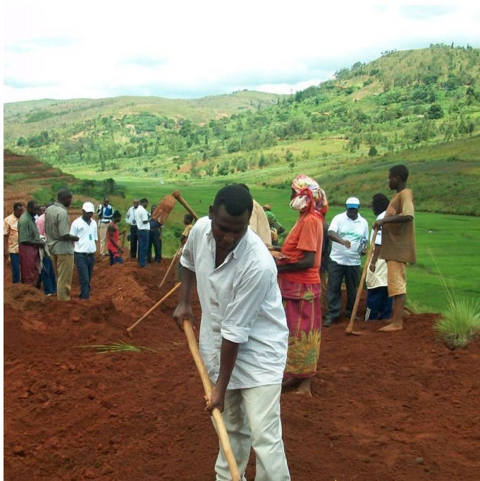
Dans le cadre de la conservation des eaux et sols, le Burundi a initié la mise en place des terrasses radicales à titre pilote. Cette activité se fait à haute intensité de main d'œuvre. (Karumbete Donatien (DPAE Gitega, e-mail : donatienkarumbete@yahoo.fr))
