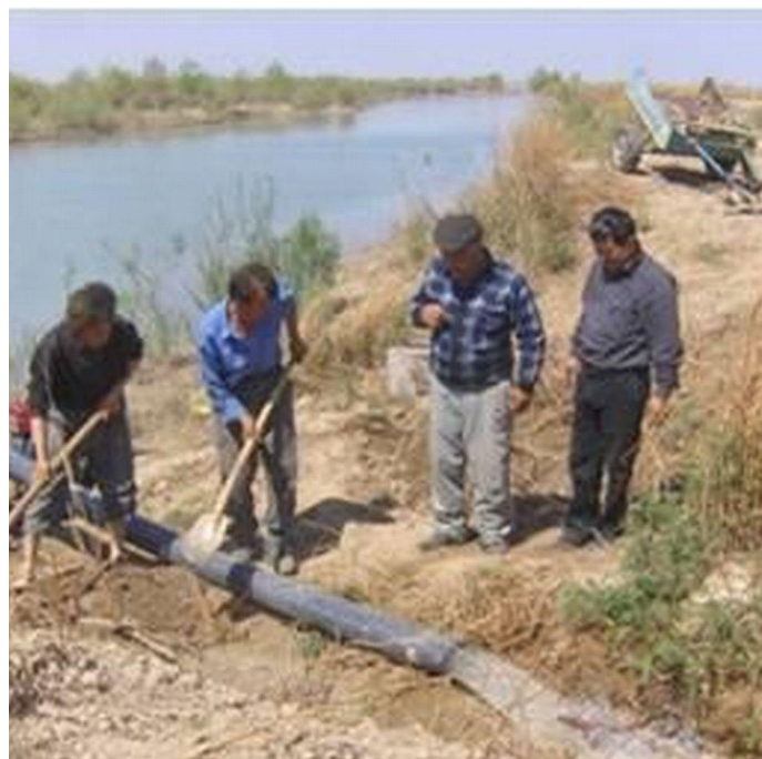
Арендаторы общинного лесоводства из числа жителей притугайных аулов, совместными усилиями устанавливают насос для организации полива саженцев. ( Б.Айбергенов (Проект ПРООН/ГЭФ,г.Нукус, Бердах гузари))
