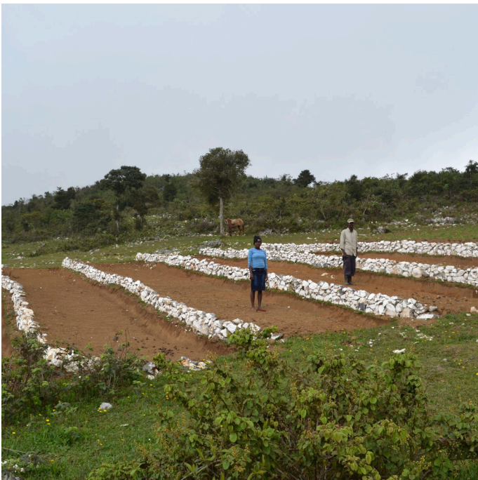
Terrasses fraîchement construites (HELVETAS)
