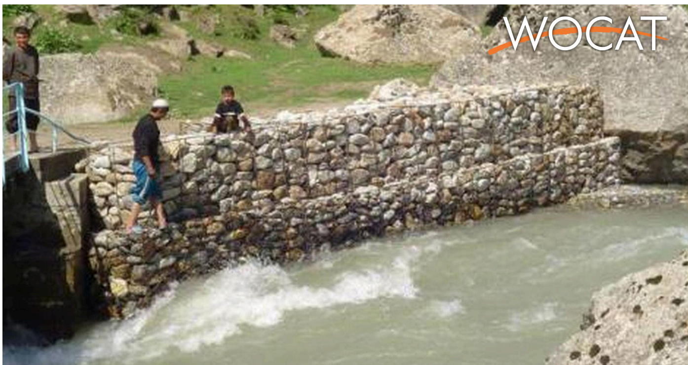
Укрепление берегов рек с помощью габионов (Архив проекта SAWMP)
