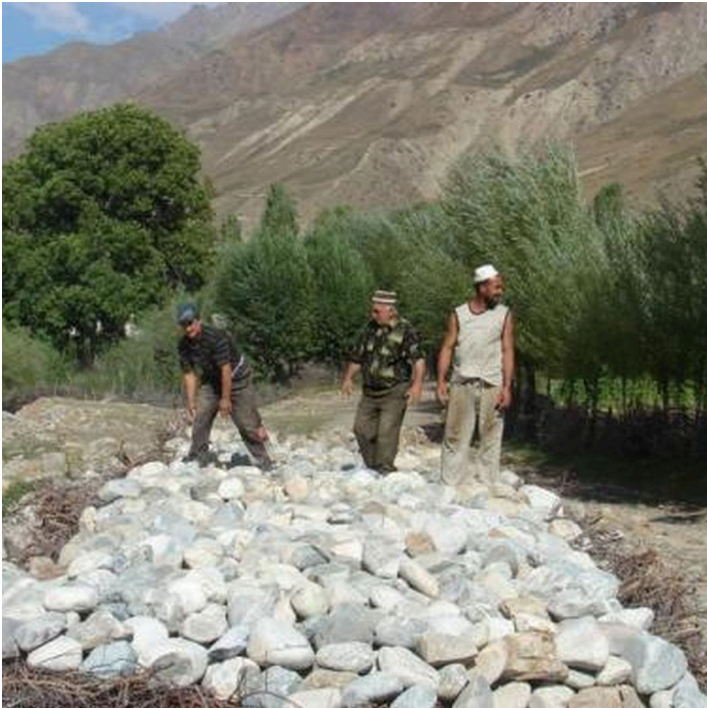
Укладка камней для предотвращения размывания берега и создания искусственной речной косы (архив проекта CAWMP)
