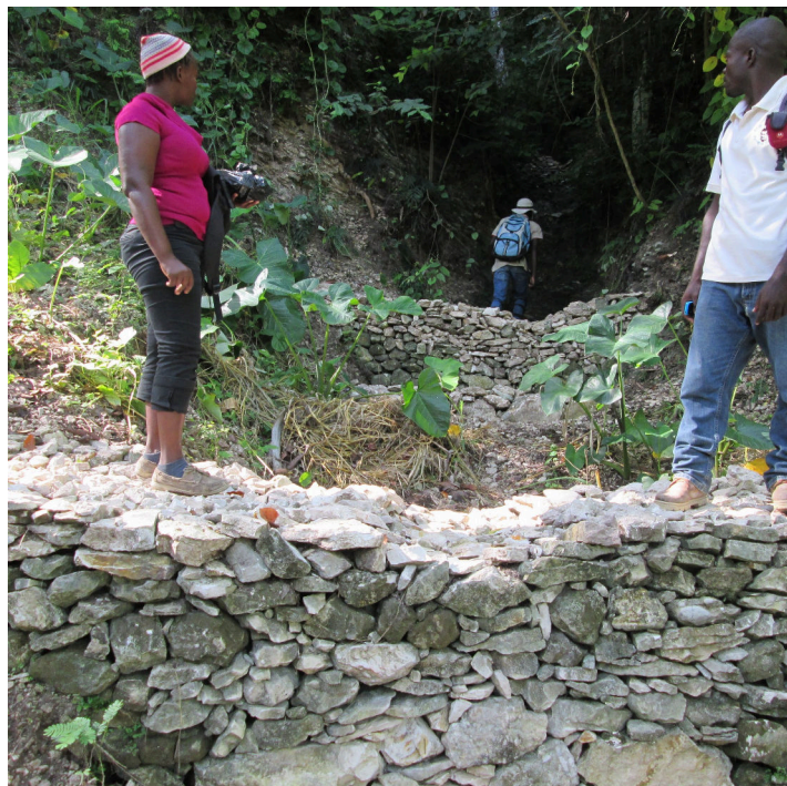
Vérification des infrastructures de protection, par le comité de gestion du service de l'eau
