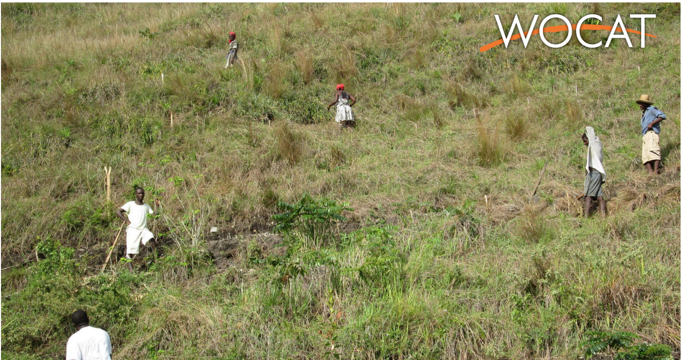
Travaux de protection des versants (Helvetas Haiti)
