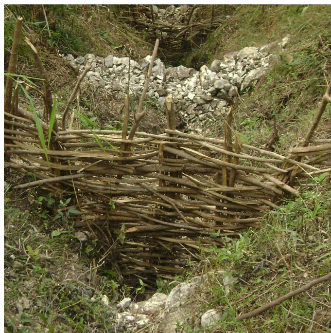
Alternance de barrière tressée et de seuils (HELVETAS)
