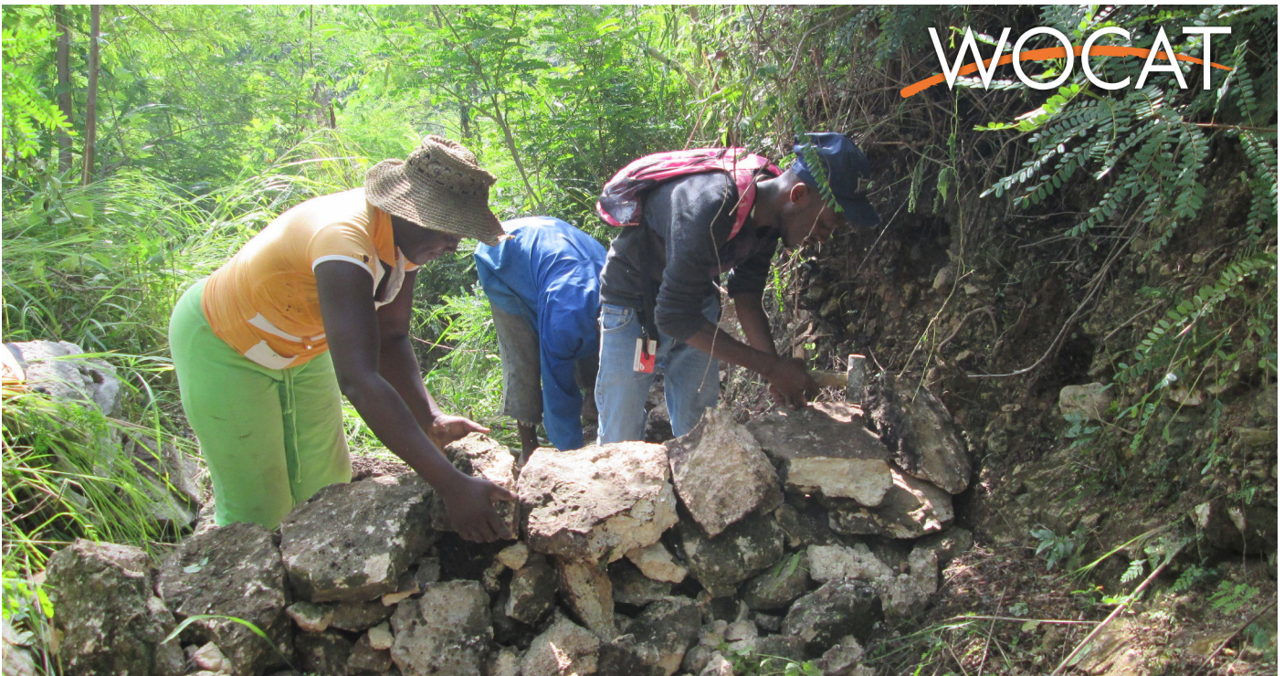
Construction d'un seuil en pierre sèche (HELVETAS)
