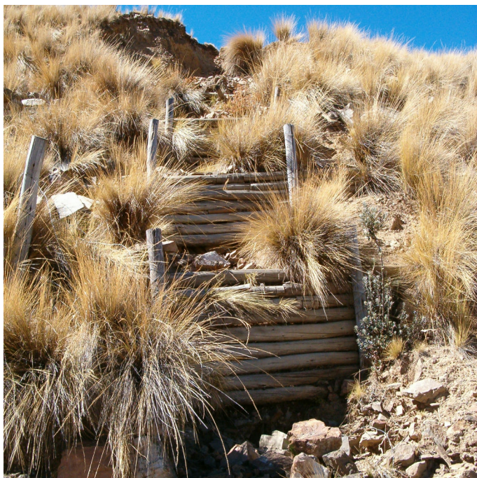
dique de madeira simple (Krainer)
