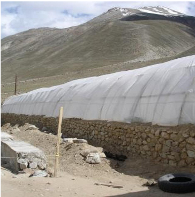
общий вид теплицы с пленочным покрытием, рядом идет строительство новой теплицы (Некушоева Гульнисо (gulniso@mail.ru, Таджикистан))
