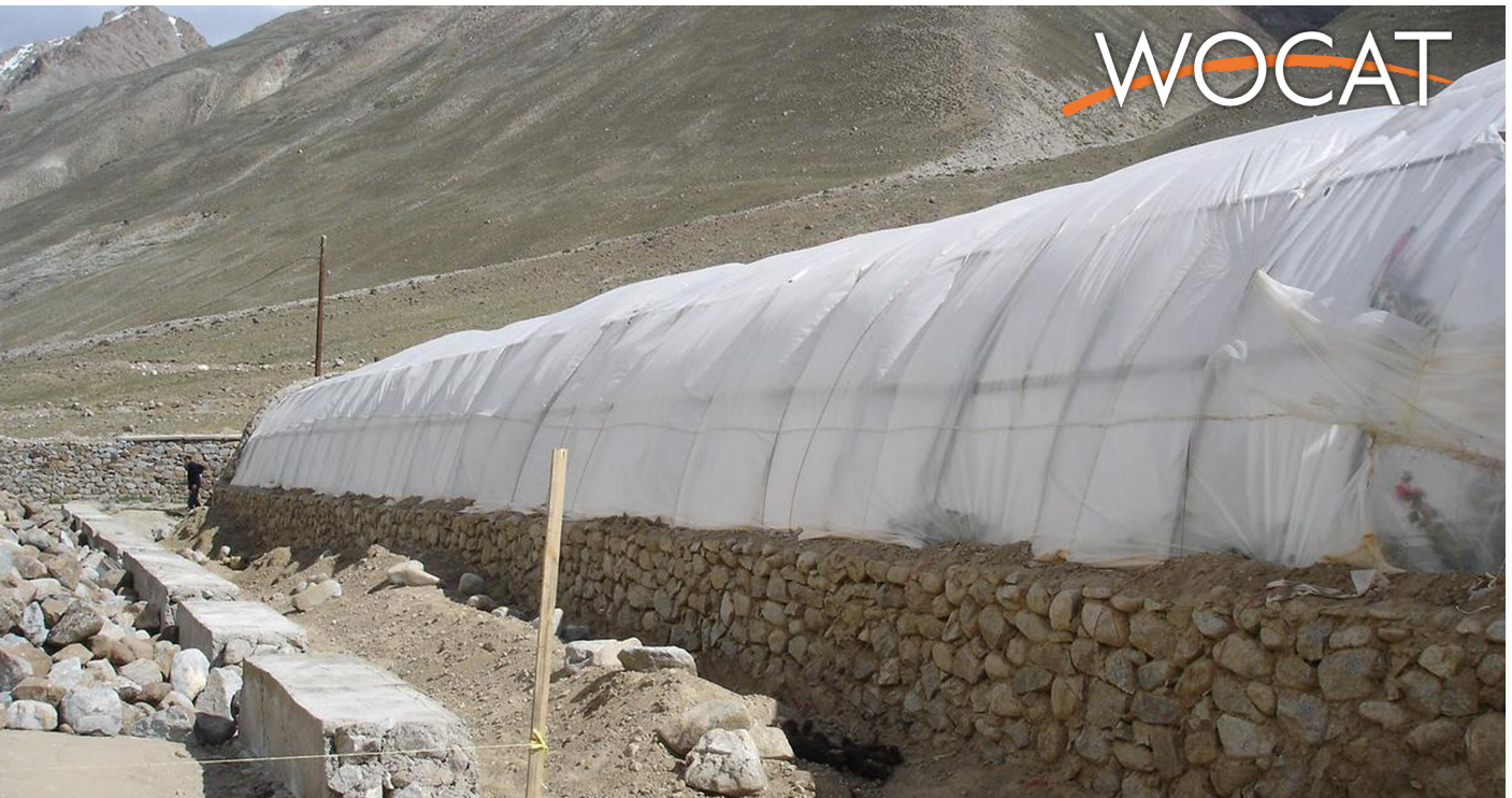
общий вид теплицы с пленочным покрытием, рядом идет строительство новой теплицы (Некушоева Гульнисо (gulniso@mail.ru, Таджикистан))
