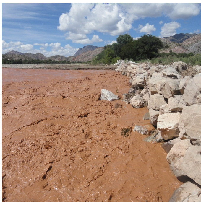
Comunitarios realizando el trabajo del acantilado de piedra (Marco Loma)
