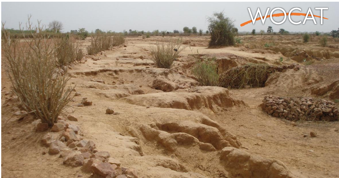
Aperçu d'érosion par ravinement atténuée par des cordons pierreux avec haie vive (à gauche) et des gabions (à droite), avec à l'arrière-plan la route protégée (Julie Zähringer (Zurich, Switzerland))
