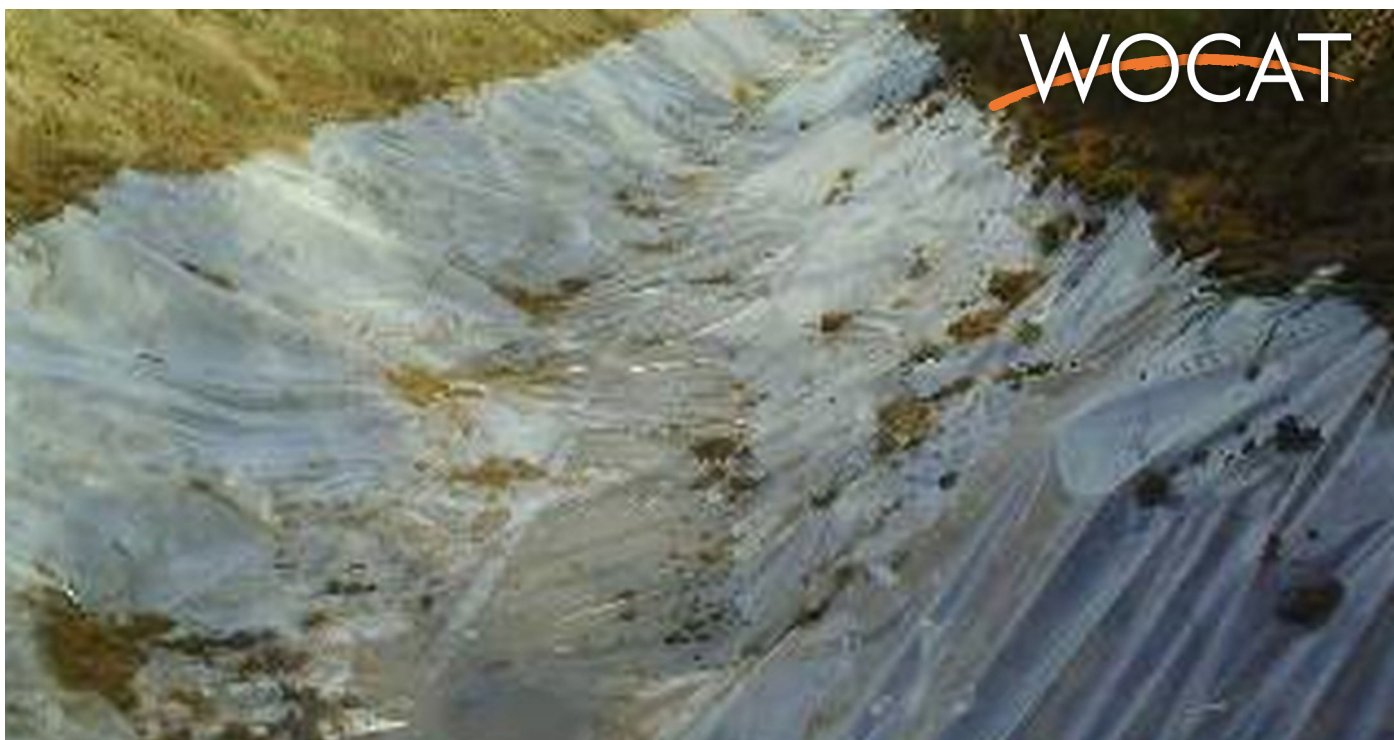
Укладка полиэтиленовой пленки (Эшчанов Р.А.)
