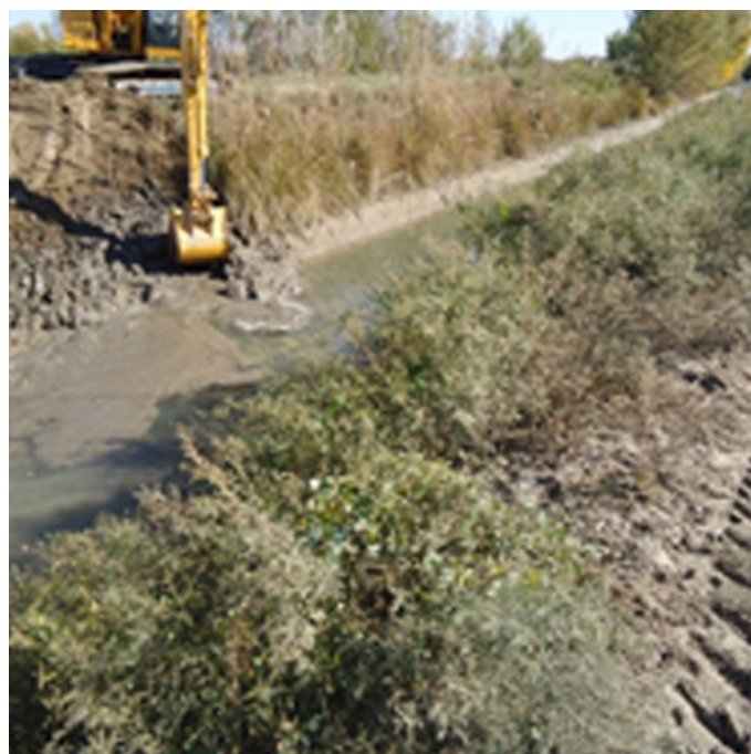
Очистка канала (Эшчанов Р.А.)
