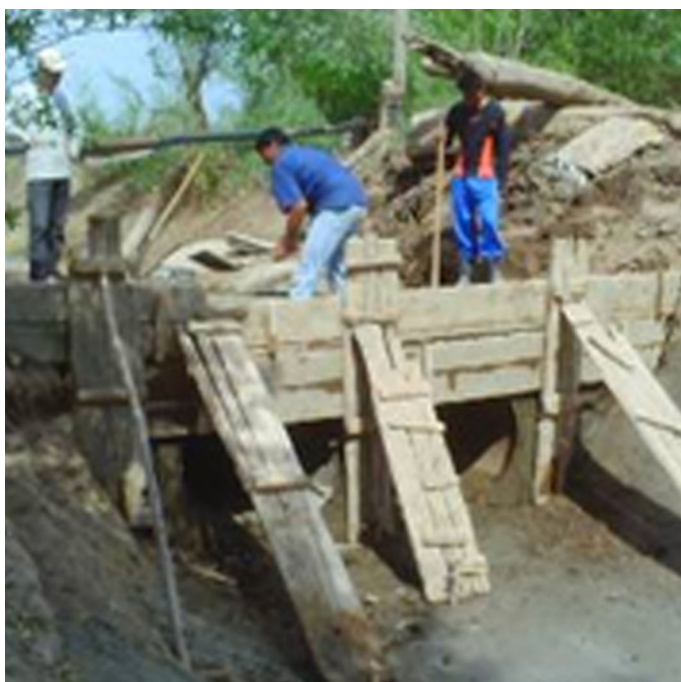
Строительство малых гидросооружений в головной части канала (Эшчанов Р.А.)
