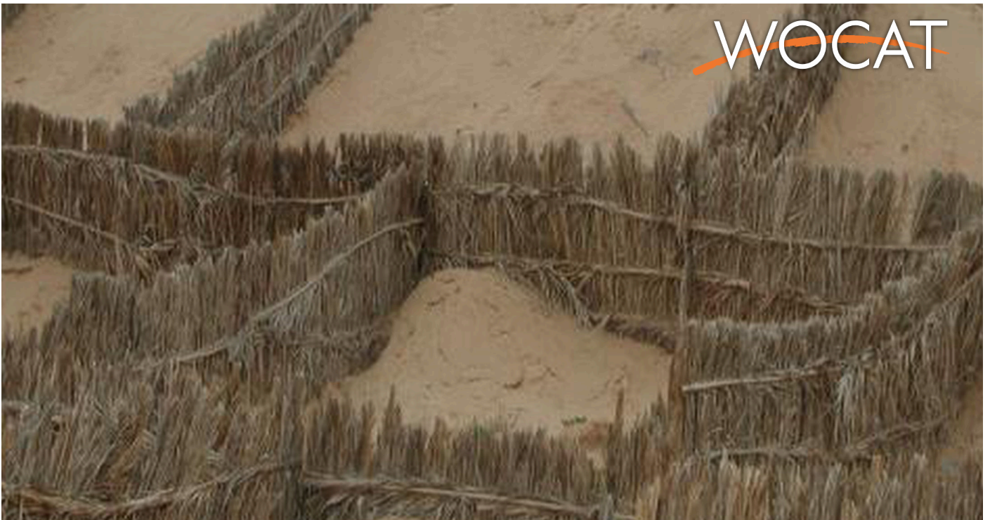
Contre dune en utilisant un croyage en feuille de palme dense. (Taamallah Houcine)
