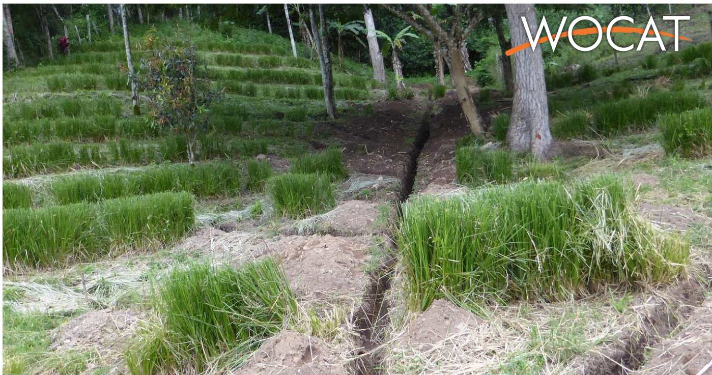
Zanjas en forma espina de pescado que van a ser rellenas con fajinas y luego cubiertos con tierra (Helen Gambon, Cruz Roja Suiza)
